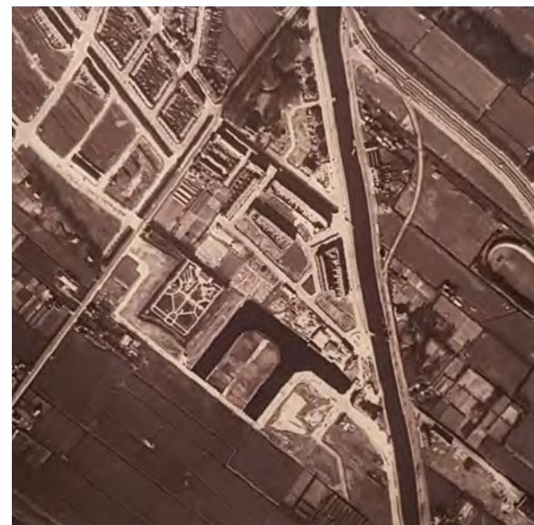
AANLEG PLASPOELPOLDER JAREN '50
